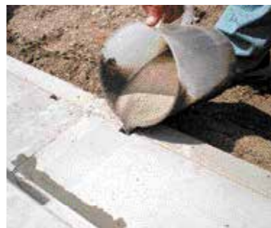
特殊モルタルで固定化
